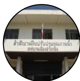
โรงปรับปรุงคุณภาพน้ำ เทศบาลเมืองอ่างทอง อ.เมืองอ่างทอง จ. อ่างทอง ครั้งที่ 1 วันที่ 18 มกราคม 2550
