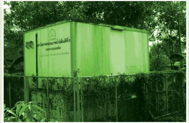
สถานีโครงการส่วนน้ำ อ.บางบาล จ.พระนครศรีอยุธยา
